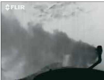
Entlüftungsüberdruckventil an einem Lagertank
